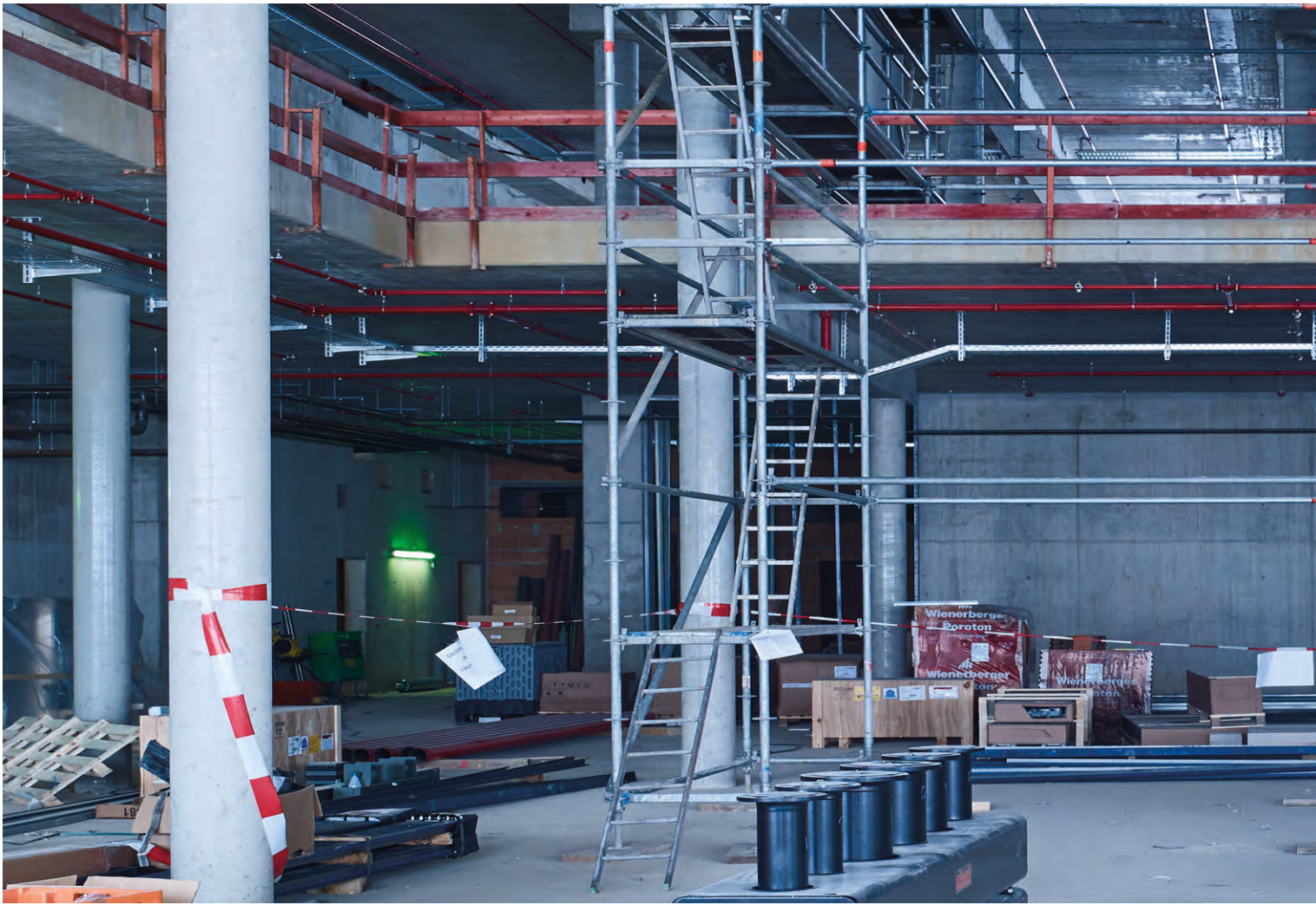
Gegenwart – Bereich Lobby, Kongresshotel, Flughafen Stuttgart
